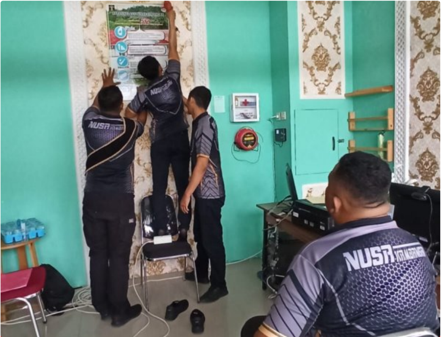
Kabapas dan Staff Renovasi Ruang Baladewa
